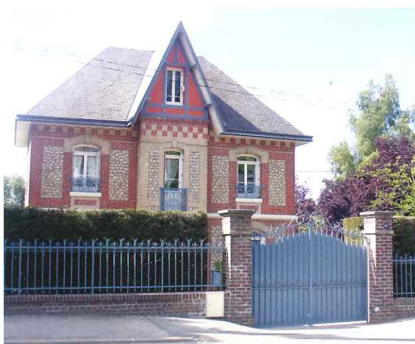
Exemple de clôture en harmonie avec la façade : matériaux (briques), couleurs..
